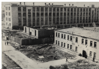
1962 год. ЗЭИМ: строящееся здание цеха №20 (впоследствии инструментально-экспериментального производства)
