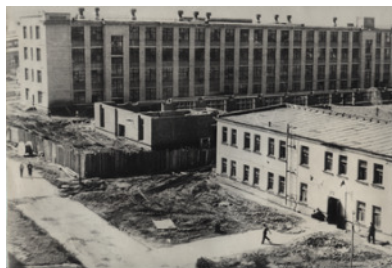
1962 год. ЗЭИМ: строящееся здание цеха №20 (впоследствии инструментально-экспериментального производства)
